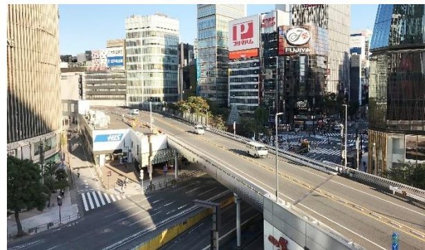
現在の東京高速道路（数寄屋橋交差点部）
