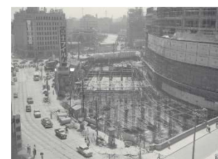
躯体工事中の北数寄屋ビル （1957/昭和 32 年）
