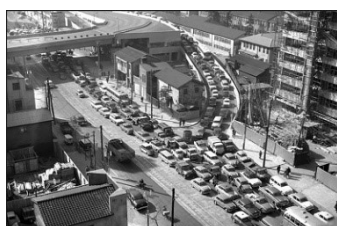
一方通行供用後の城辺橋出口 （1960/昭和 35 年）
